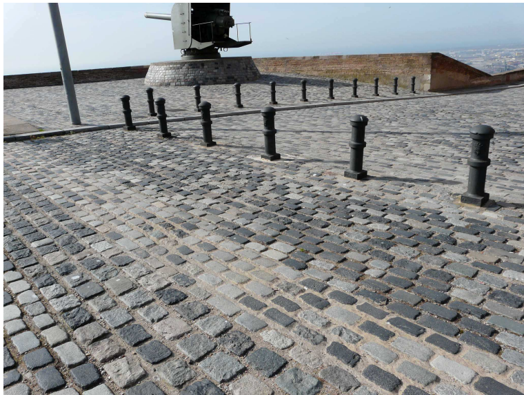
Vista del paviment actual de llamborda que ocupa la part baixa del baluard de Sant Carles i tota la cortina de mar
