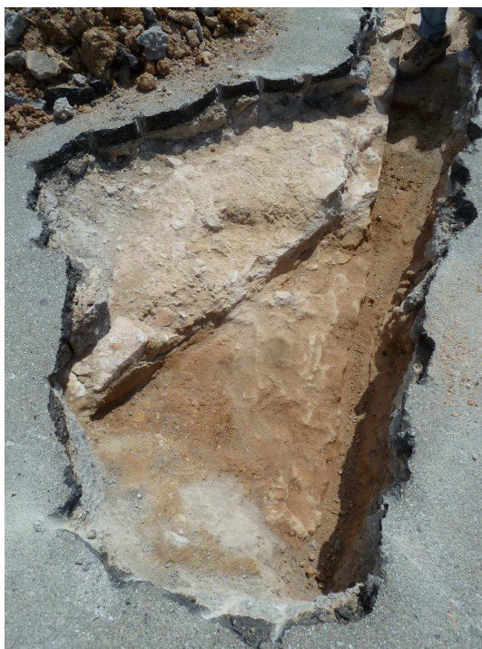
Vista del tram final del sondeig. S'observa el gir del mur del corredor de la garita per configurar el parapet i també la seva continuïtat almenys a nivell de fonament.
