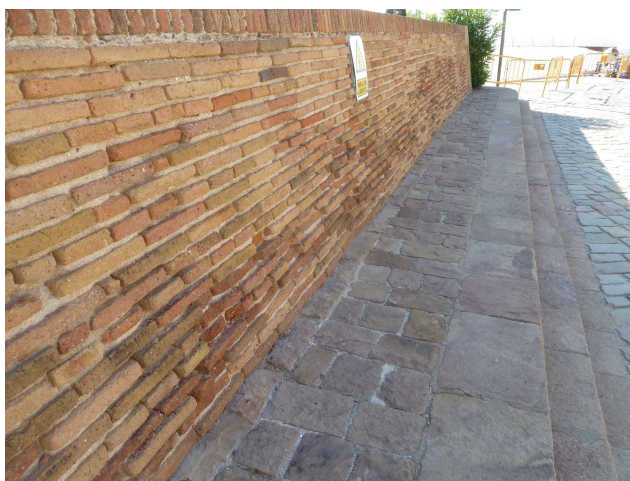
Vista general de la vorera i l'escala
