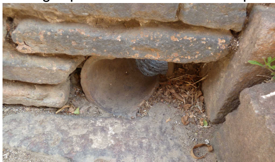
A esquerra i dreta, entrada i sortida del desguàs de la garita de Santa Amalia mitjançant un tub de ceràmica. Aquest sistema segurament és aplicable a les garites de Sant Carles.
