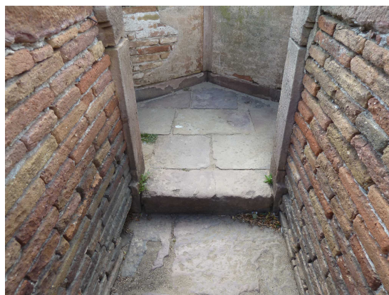
Vista d'una de les garites de Santa Amalia on encara es conserva intacte el sistema original de desguàs. Al final del corredor el marxapeu desvia l'aigua cap al forat que hi ha a la paret, a baix a l'esquerra de la foto.
