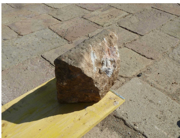
Detall de la forma i el gruix d'una de les pedres del paviment de la plataforma
