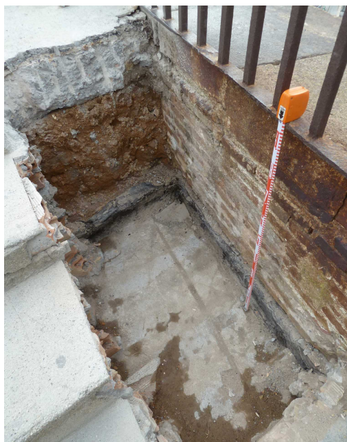
Vista de la continuació de l'ampit original
