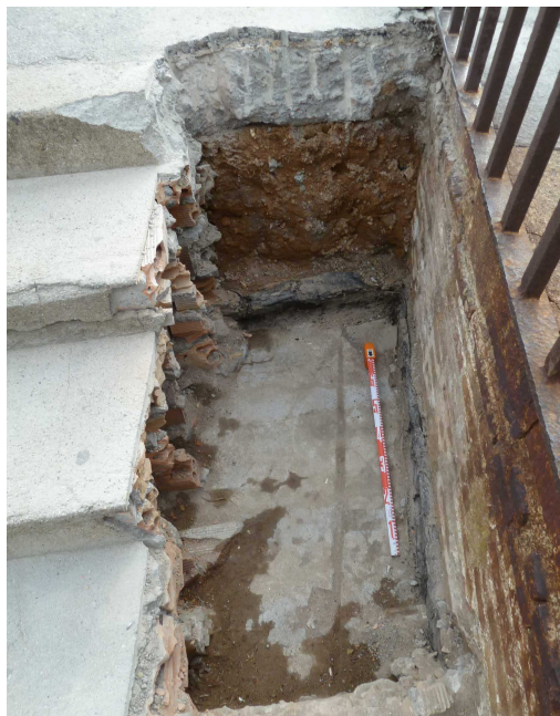
Vista de l'estructura de l'escala i del retall que es va generar en el rebliment del baluard per construir-la.
