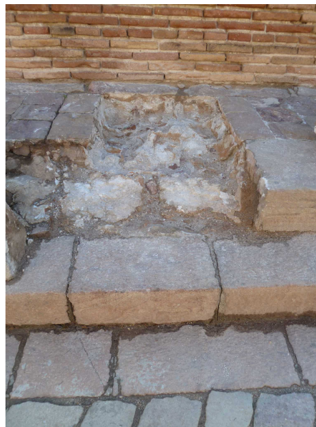
Detall del massissat de morter i pedra sobre el que s'assenten les llambordes de la vorera
