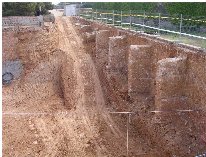
Vista general dels contraforts o estreps, apareguts en el marc de la intervenció i que reforcen internament la contraescarpa del fossat i que delimiten interiorment el camí cobert de Montjuïc (Foto Daniel Alcubierre)
