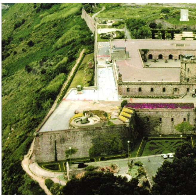
Detall del baluard durant els treballs d'impermeabilització dels anys 70 o 80. Foto: M. Catalán
