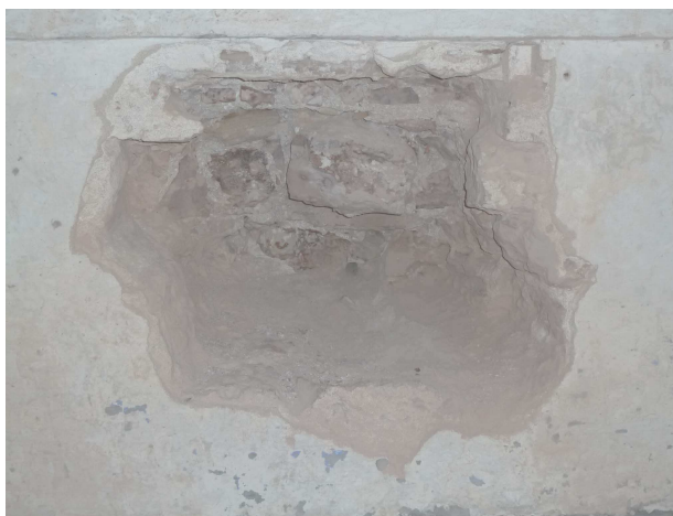
Vista del sondeig 8. A la part central s'observa el forat de la broca.
