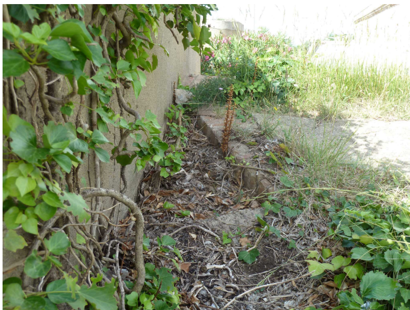
Vista general de la traça del mur d'una de les antigues troneres que s'ha conservat en el límit de la bateria de costa.
