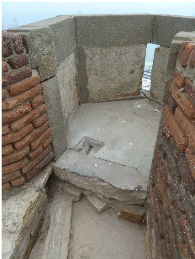
Vista del marxapeu de la garita
