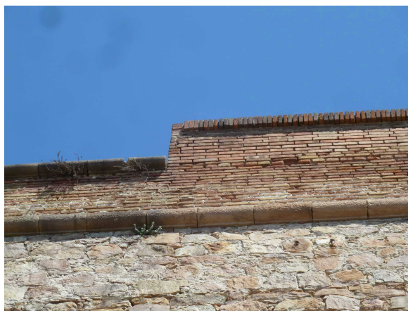
Vista exterior del canvi de nivell en el mur de tancament del baluard. S'observa la continuïtat de la cara exterior de maons d'un costat a l'altre així com les diferències amb la part superior que correspon a la reconstrucció moderna.
