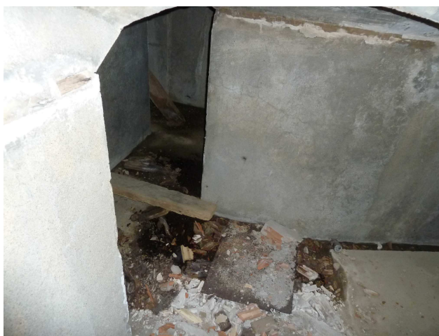
Vista de l'interior d'aquesta estructura soterrada
