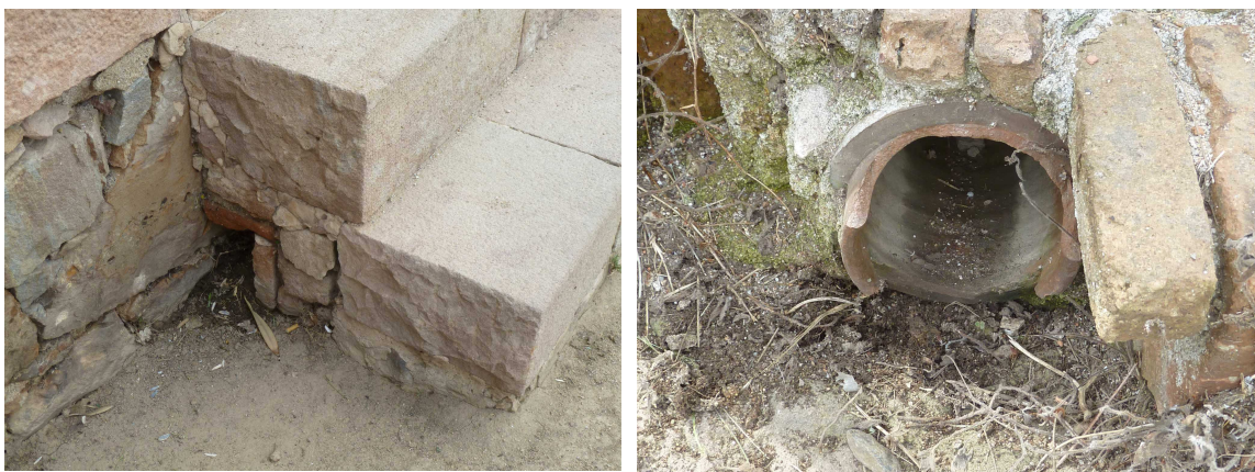
A l'esquerra l'obertura que es va deixar sota l'escala que es va afegir davant la paret del parapet i que tapava l'entrada del desguàs original. A la dreta el tub ceràmic que desguassa a l'exterior del parapet
